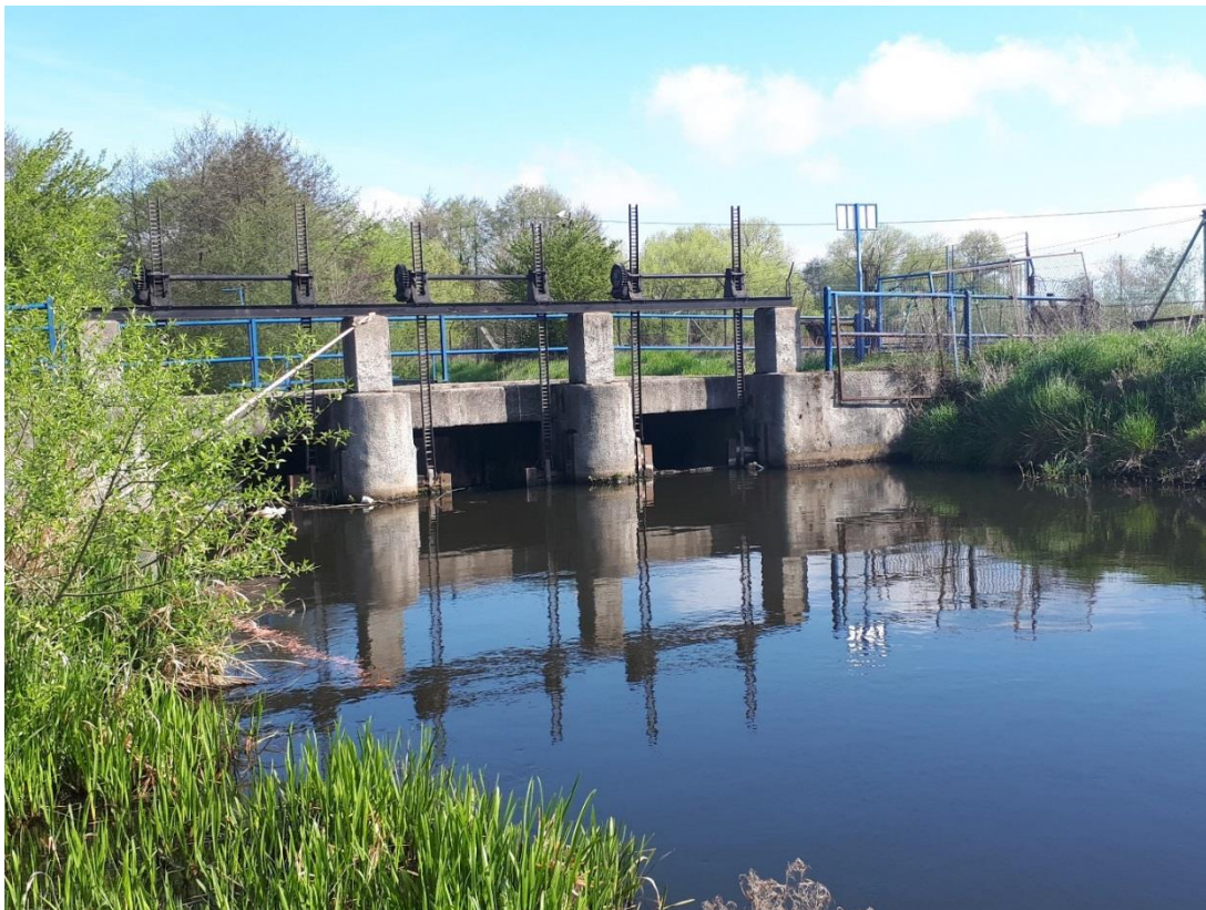
Fot. 1. Jaz główny na rzece Redzie w miejscowości Reda Ciechocino widziany od strony górnej wody. Powyżej część spiętrzonych jazami wód Redy daje początek Kanałowi Mrzezińskiemu oraz Kanałowi Łyskiemu.
