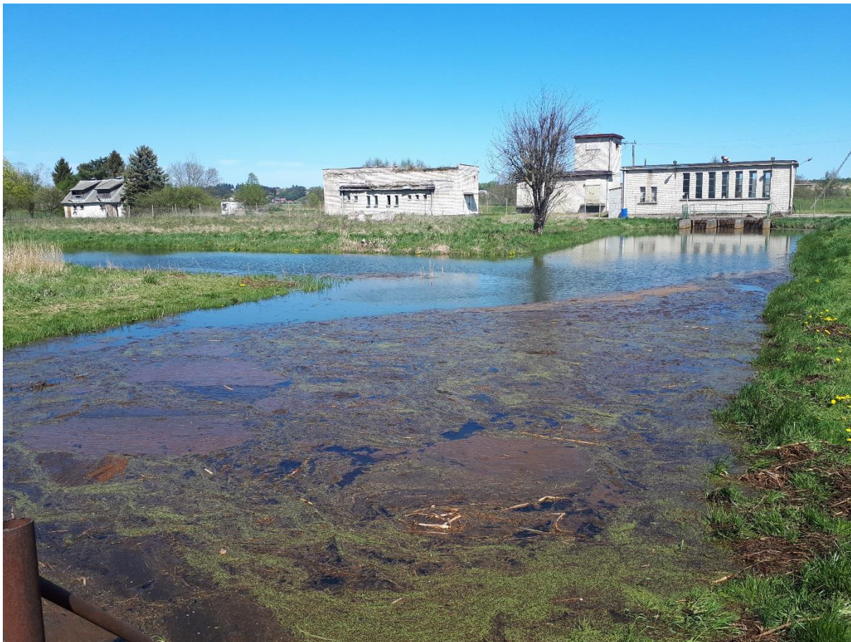
Fot. 14. Kanał A (na pierwszym planie) oraz Kanał B (z lewej). W tle widoczna przepompownia zlokalizowana na prawym (południowym) brzegu Redy.
