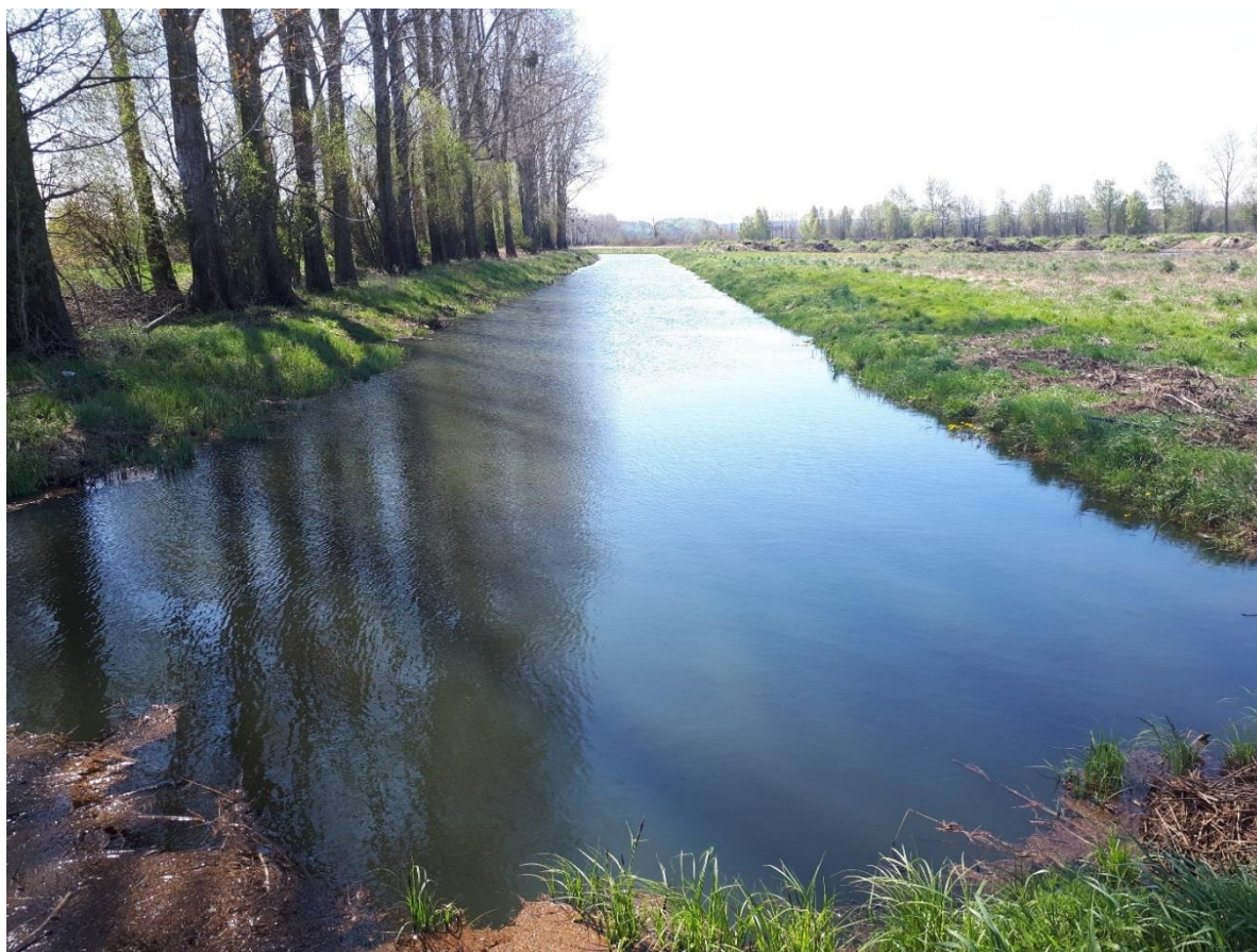
Fot. 13. Kanał A przebiegający na prawym (południowym) brzegu Redy.
