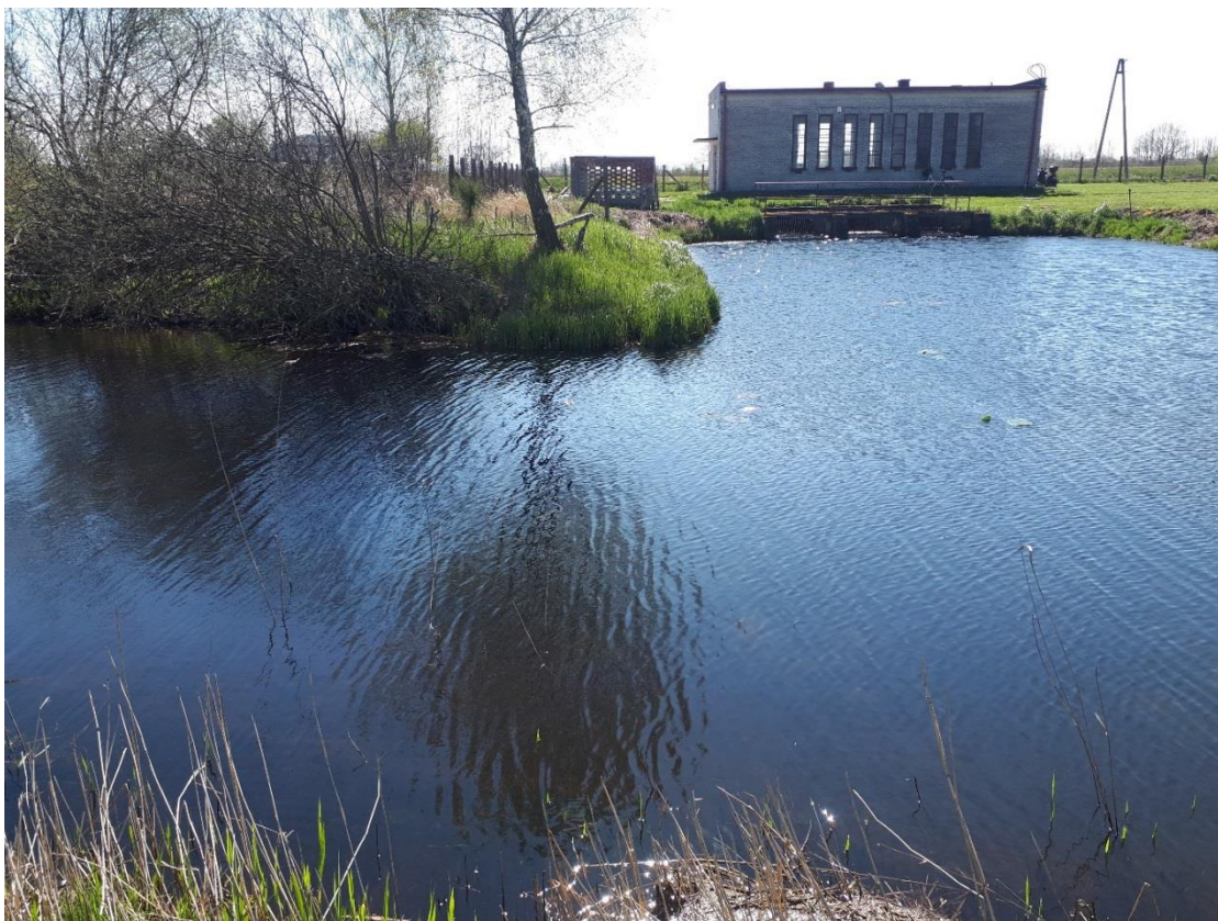
Fot. 8. Kanał A oraz Kanał B kończące swój bieg w przepompowni zlokalizowanej na lewym (północnym) brzegu Redy.
